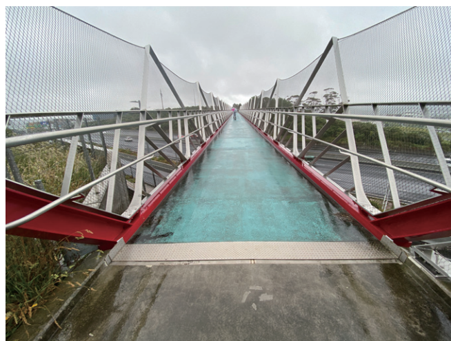
写真－4.3.2 V字の橋面とUVカット効果のデッキ
