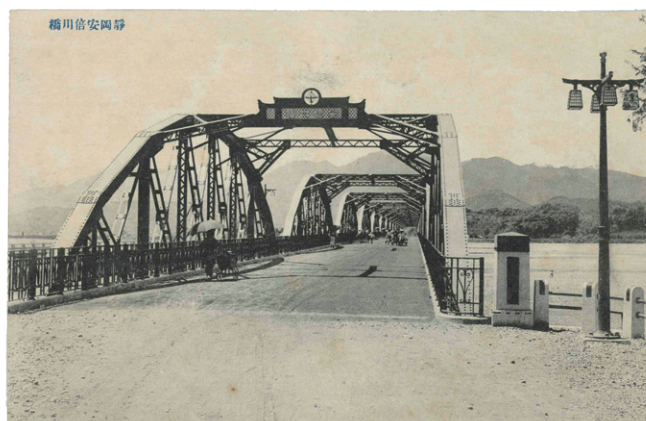
写真3：建設当時の安倍川橋
