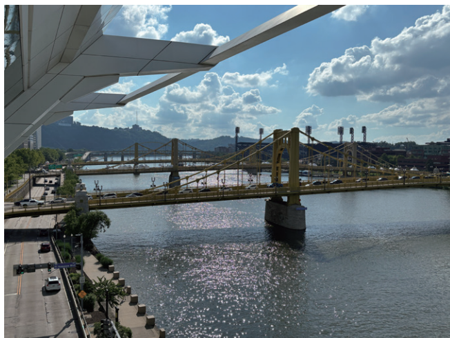
写真-9 スリーシスターズブリッジの全景
