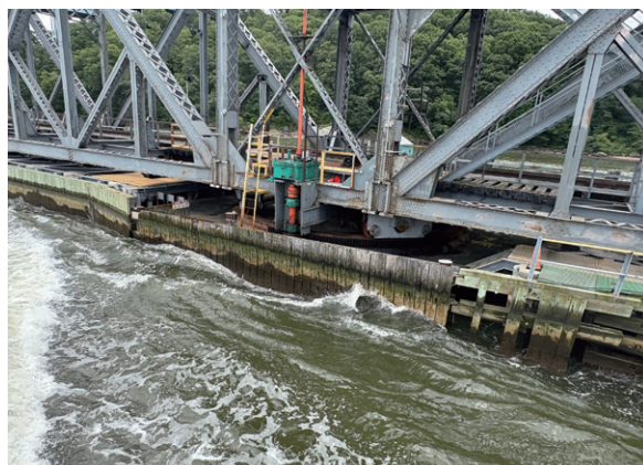
写真－24 旋回部の状況
