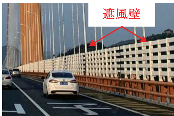
図-2 西候門大橋の全橋に設置された遮風壁
