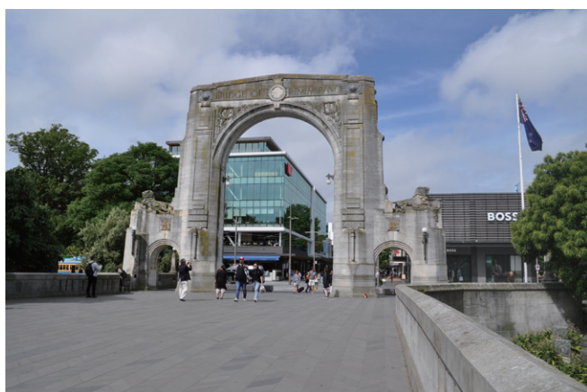
写真-3.1.2 メモリアルアーチ
