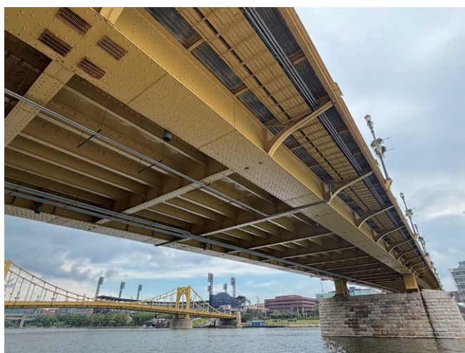
写真-11 Andy Warhol Bridgeの桁下状況
