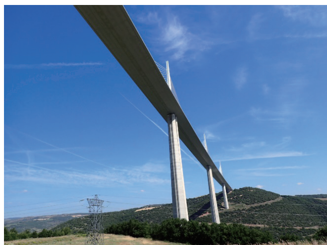
写真－8 P4橋脚より起点方向を臨む
