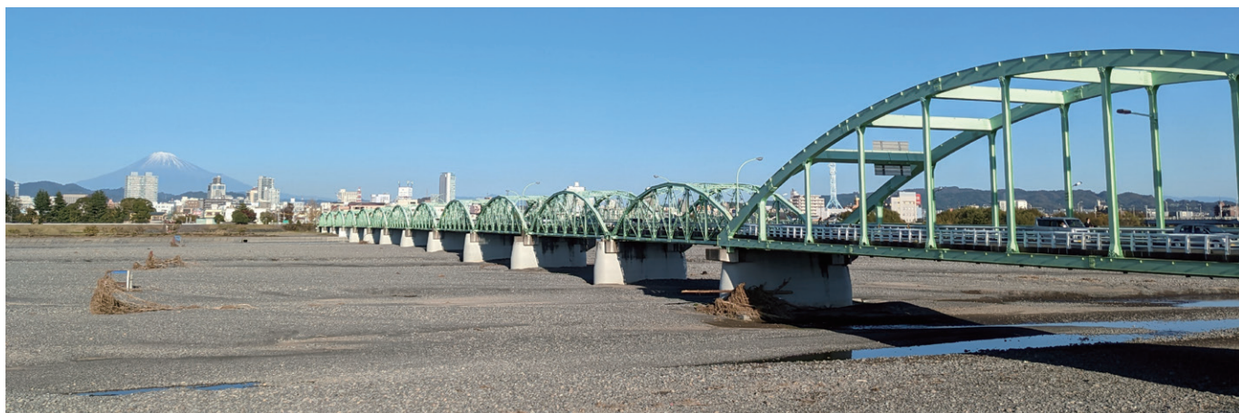
写真1：安倍川右岸から安倍川橋・富士山を望む
