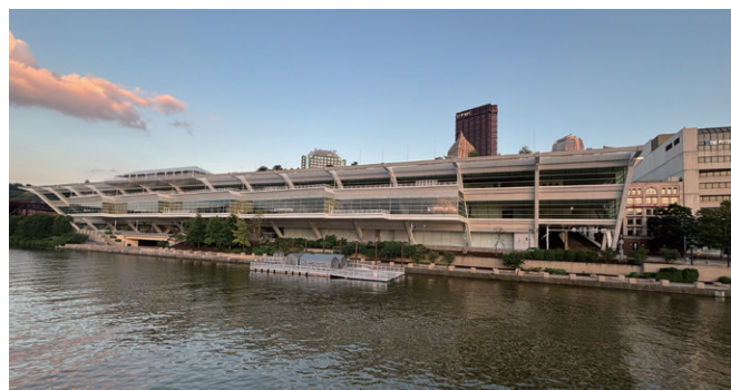
写真-1 IBC 2025 Pittsburgh会議場
