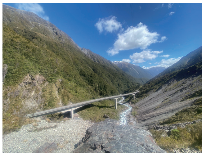
写真-3.3.1 オティラ高架橋
