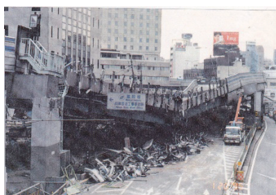
b) 弁天町高架橋（神戸線）
