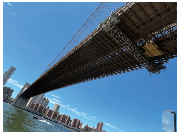
写真－20 Brooklyn Bridgeの桁下状況
