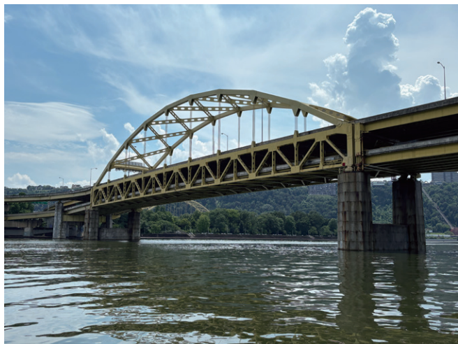
写真－12 Fort Duquesne Bridgeの全景
