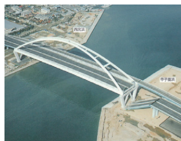
c) 西宮港大橋隣接桁（湾岸線）
