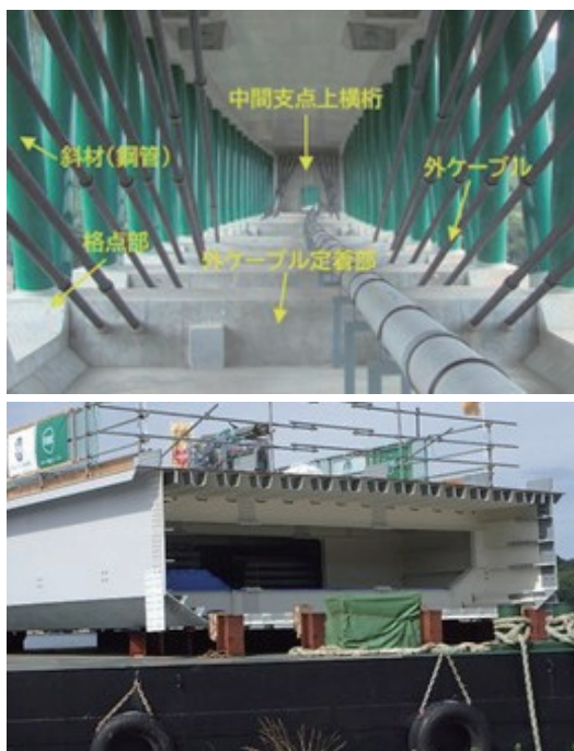
図-3-2 特殊な構造形式の主桁の例
